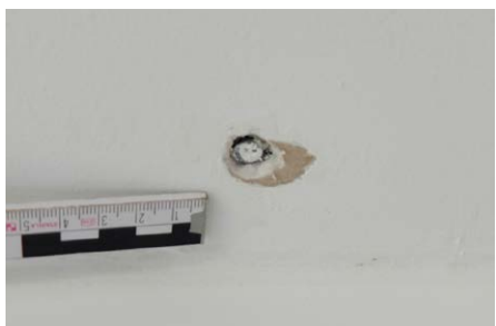
(6) Ein sich abzeichnender Schraubenkopf an der Dachuntersicht
