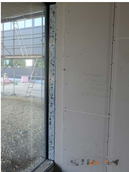
(2) Schwert zum Anschluss der Trockenbauwand an die Pfostenriegel-Fassade (noch einseitig geöffnet)
