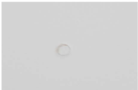
(5) Ein sich abzeichnender Schraubenkopf an der Dachuntersicht
