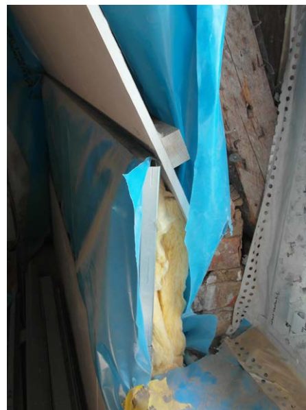
(1) Problematischer Wechsel der luftdichten Ebene ohne Verbindung
