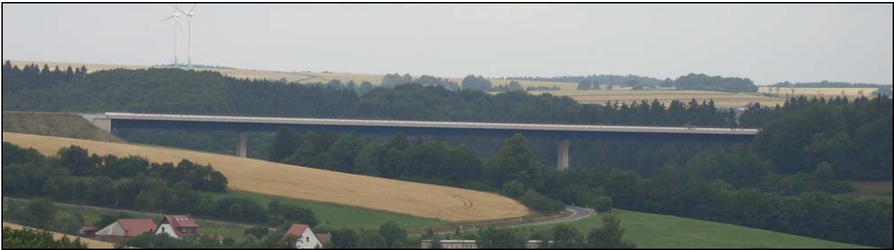
Fig. 1. Die Steinbachtalbrücke auf der Südharsautobahn (A38) bei Bodenrode, Thüringen, Deutschland.
