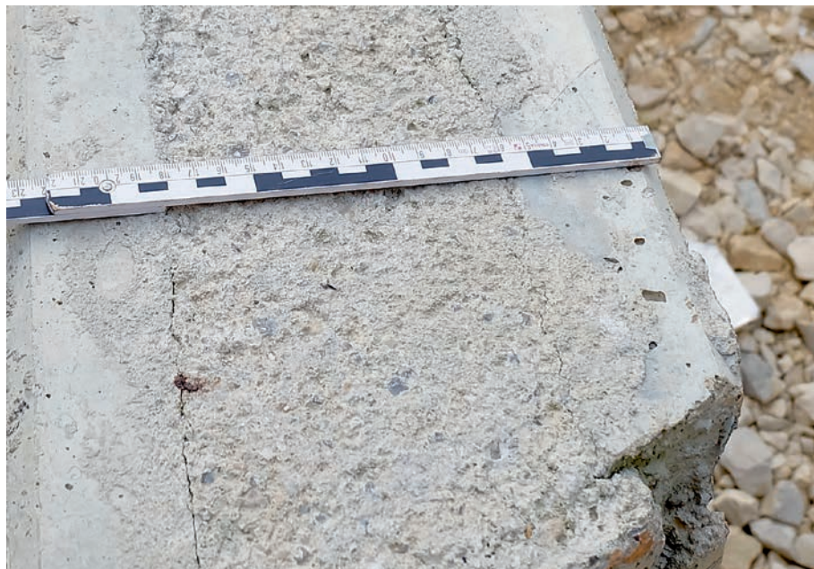
(4) Teilfertigteil-Wände mit Ortbetonzwischenicht – bei Sichtbetonanforderungen muss die Fläche großflächig überarbeitet werden. Hier sollte auf der Oberseite entweder eine Abdeckung und/oder eine rissüberbrückende Abdichtung aufgetragen werden.
