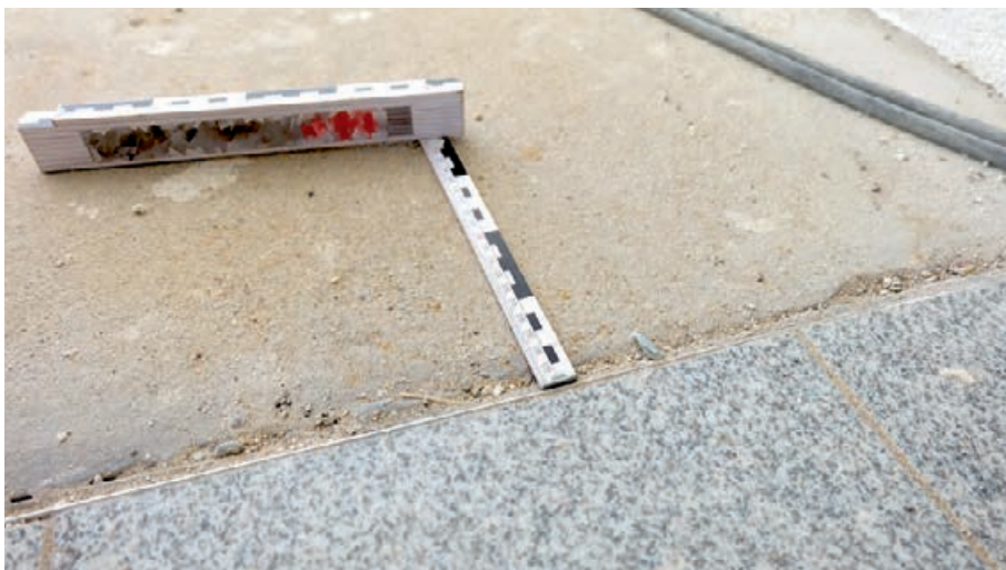
(3) Geringer Höhenversatz zwischen Estrich (= Fertigfußboden) und Natursteinbelag
