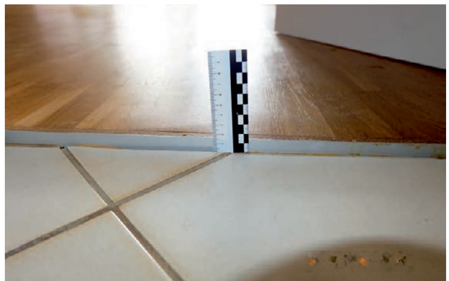
(6) Höhenversatz zwischen Alt- und Neubelag von 17 mm
